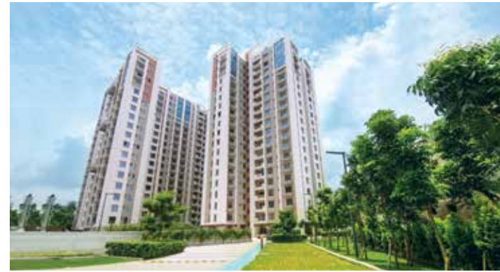
OZONE On South EM Bypass
