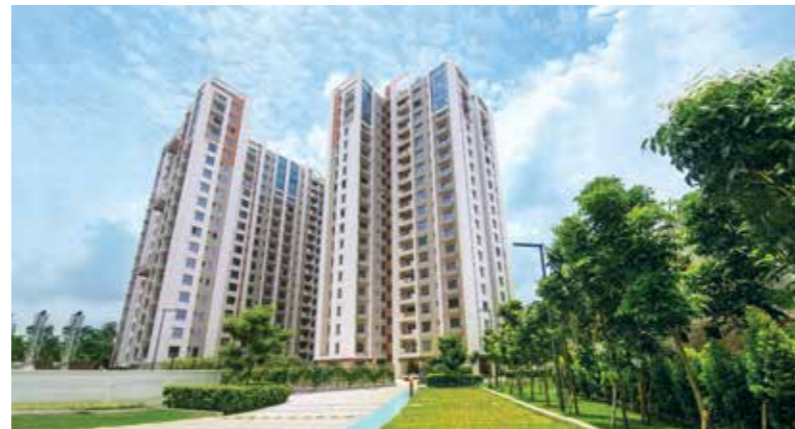
OZONE On South EM Bypass
